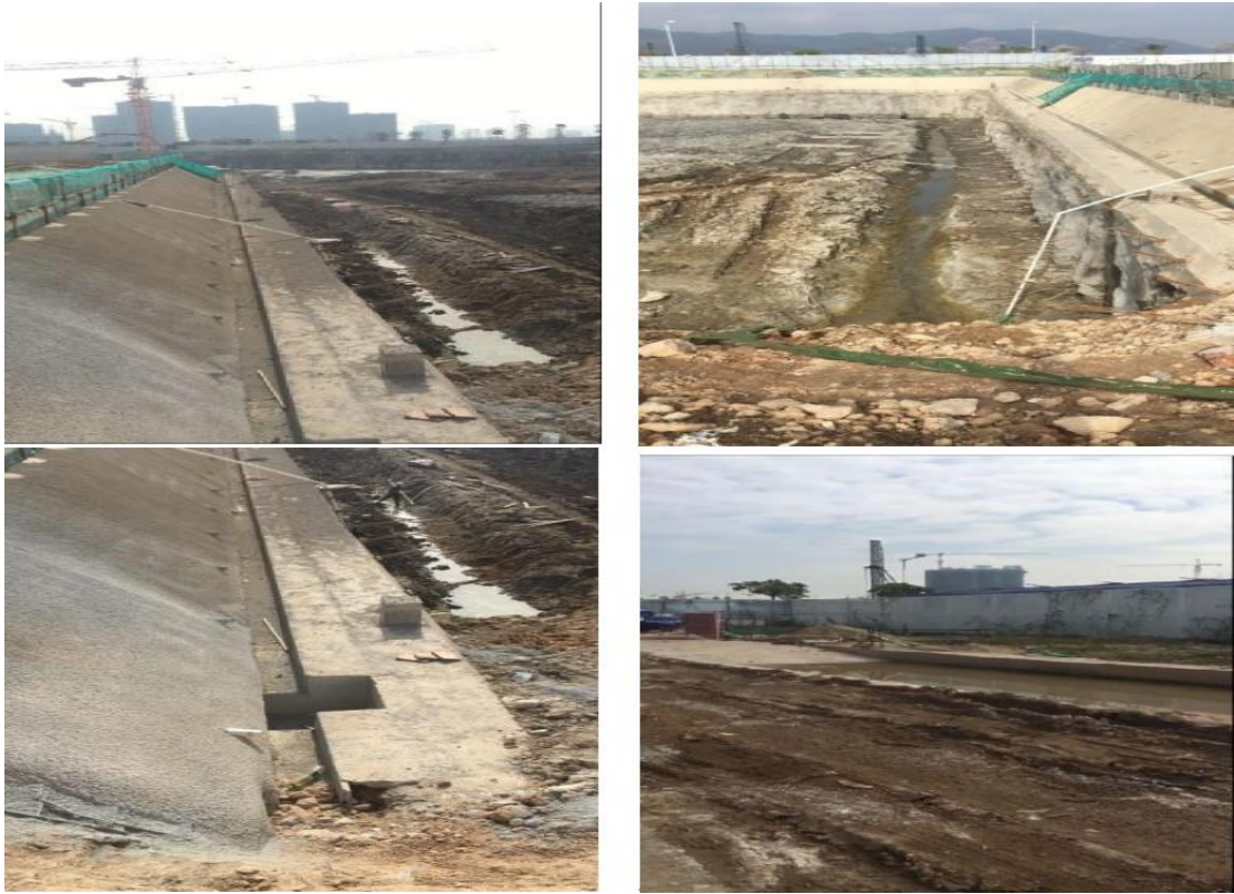
基坑施工过程照片
