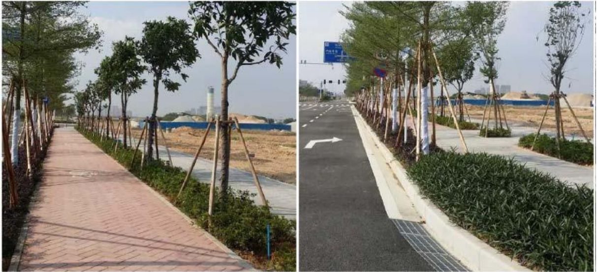
图 1.1-4 片区其他道路铺装现状图
