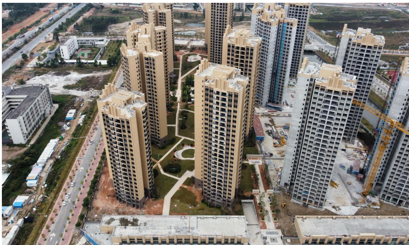
施工过程中航拍图（2021 年 11 月）
