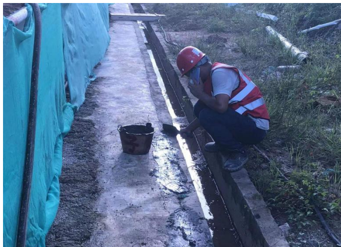
临时排水沟、雨水管线施工过程照片
