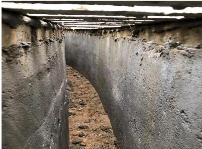
临时排水沟、雨水管线施工过程照片
