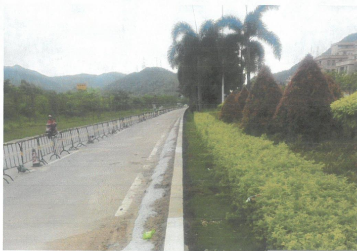
施工完成后绿化保留及恢复
