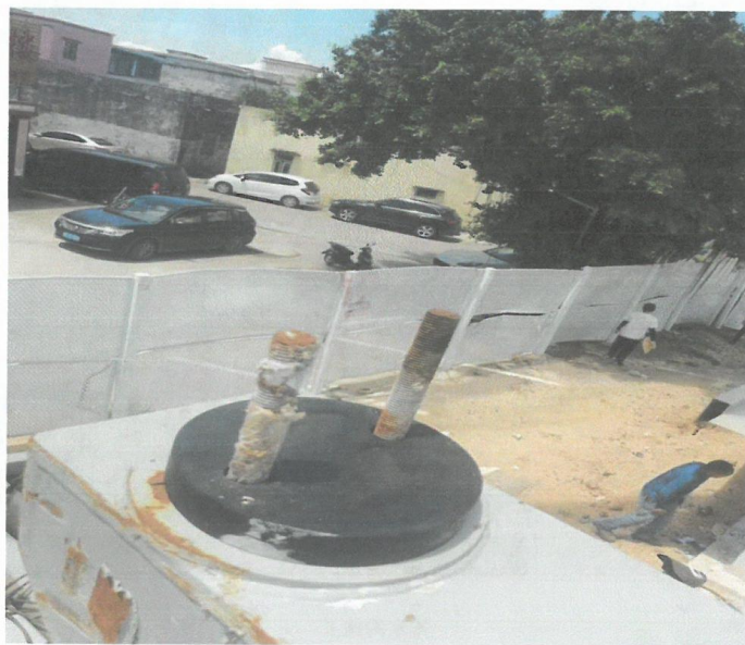
居民区围蔽施工
