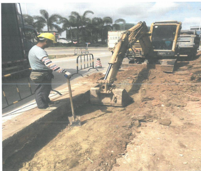
路槽开挖施工
