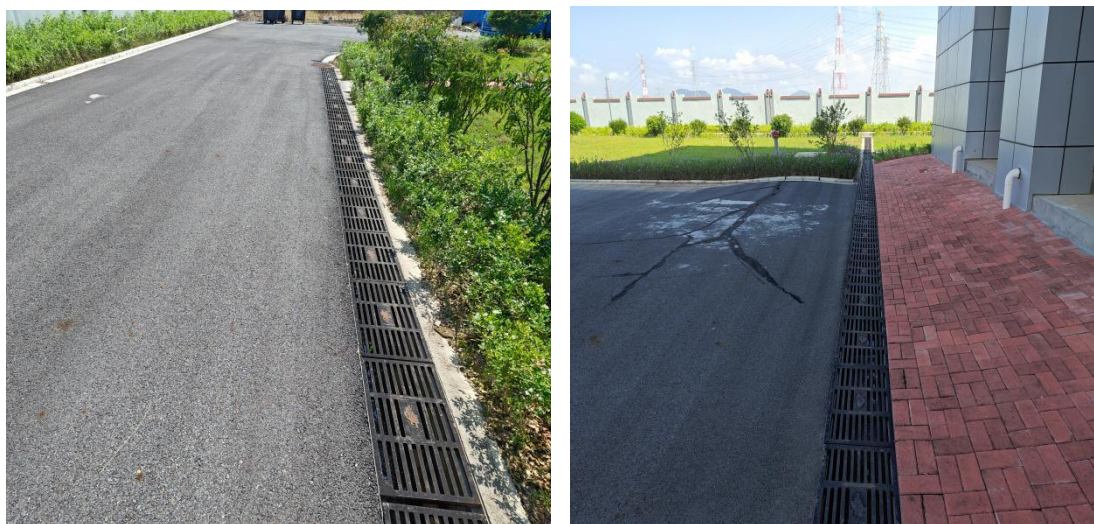
图 4.1-2 浆砌石排水沟
