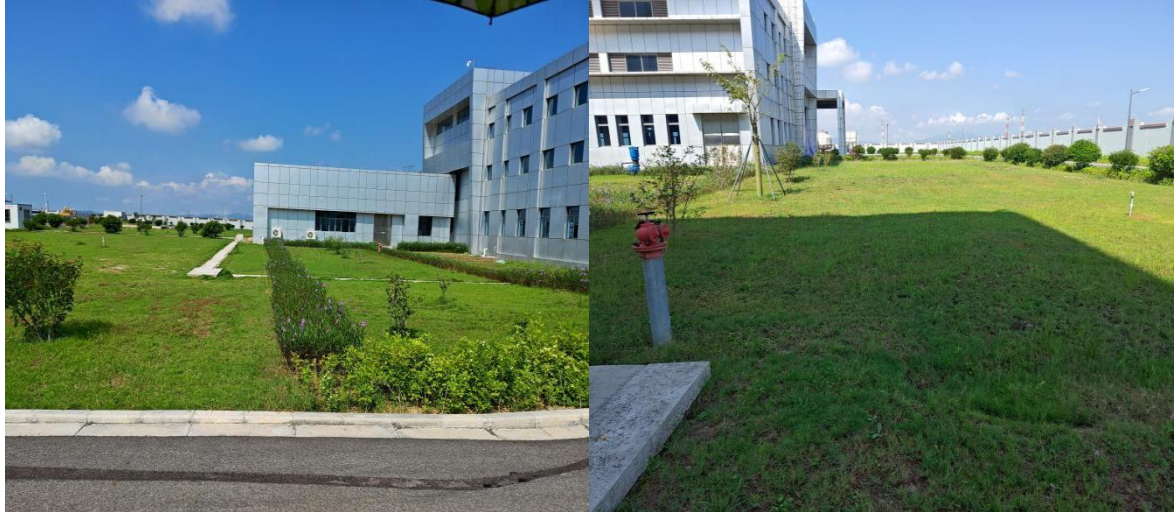
新建广昌泵站内部绿化二
