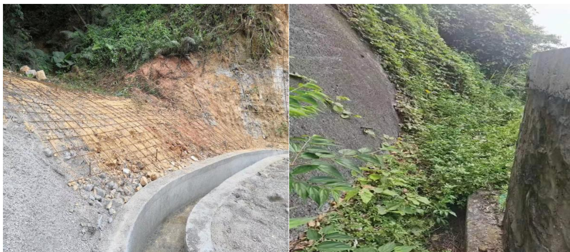
输水隧洞截水沟
