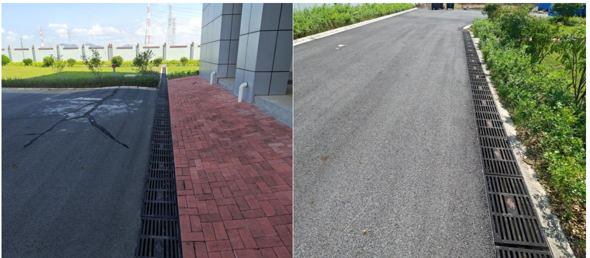
新建广昌泵站内部排水沟
