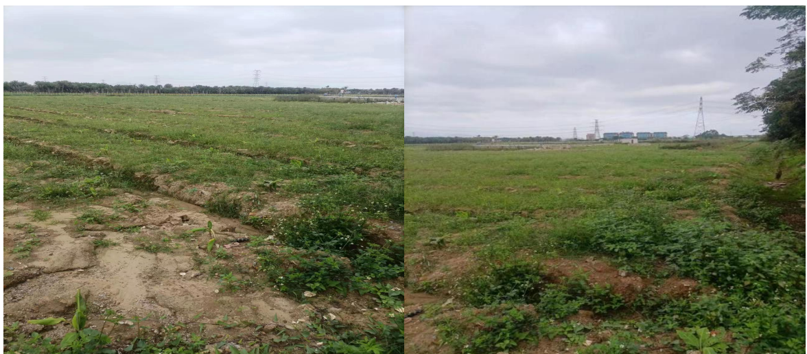
管线区复垦后现状
