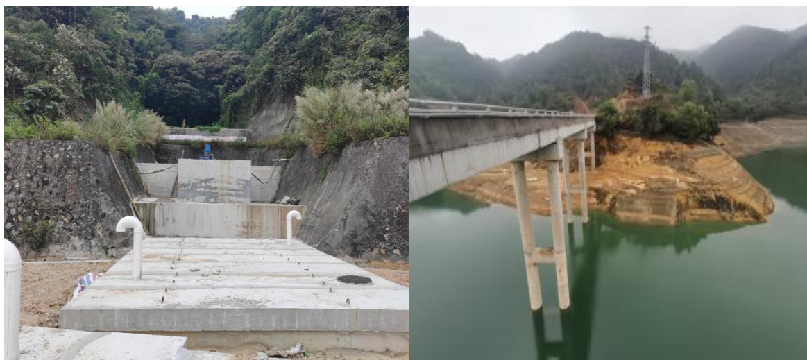
输水隧洞现状一
