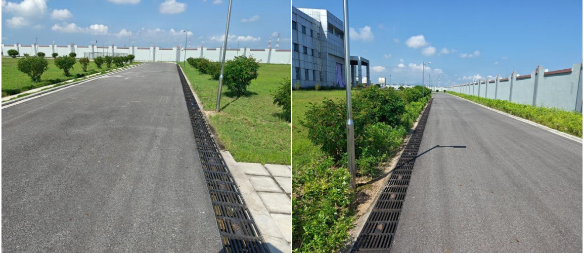
新建广昌泵站内部道路及排水沟
