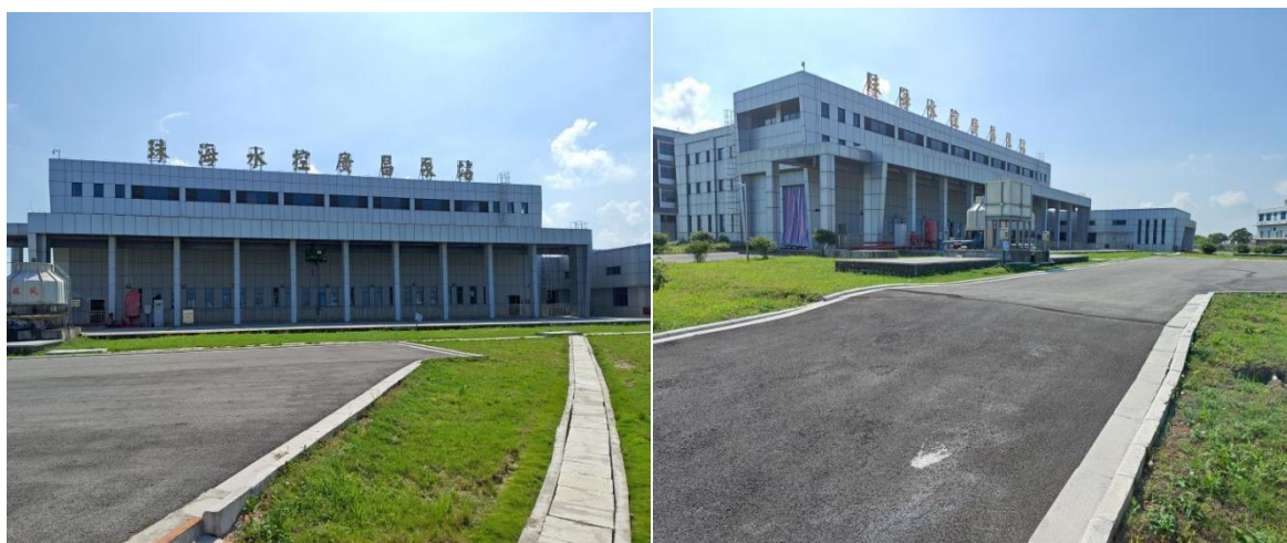
新建广昌泵站现状一
