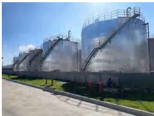
储罐区设置围堰（防火堤）
