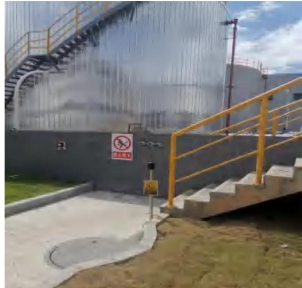
储罐区收集沟，防爆、防静电、泄漏报警措施
