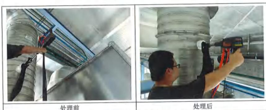
图 5: 有组织废气监测口 JW-FQ-0963-6 现场采样图
