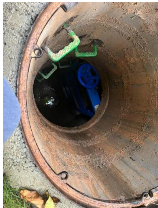
园区雨水总排口2号雨水阀门
