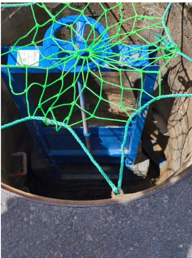
园区雨水总排口 1 号雨水阀门
